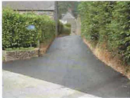
Les travaux de voirie de la Mulosière sont terminés avec le concours de la CCSN
