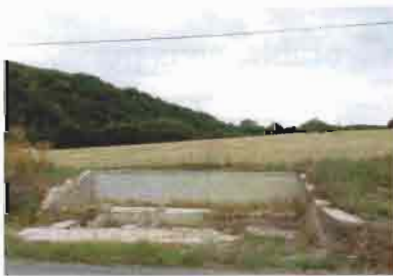
Consolidation du lavoir du Pont de la mousse
