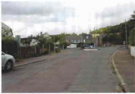
1 ère tranche de travaux rue Launay finie, l'effacement de réseau débutera cet automne
