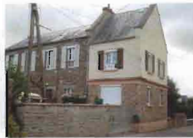
Huisseries changées dans le logement du 1 er étage
